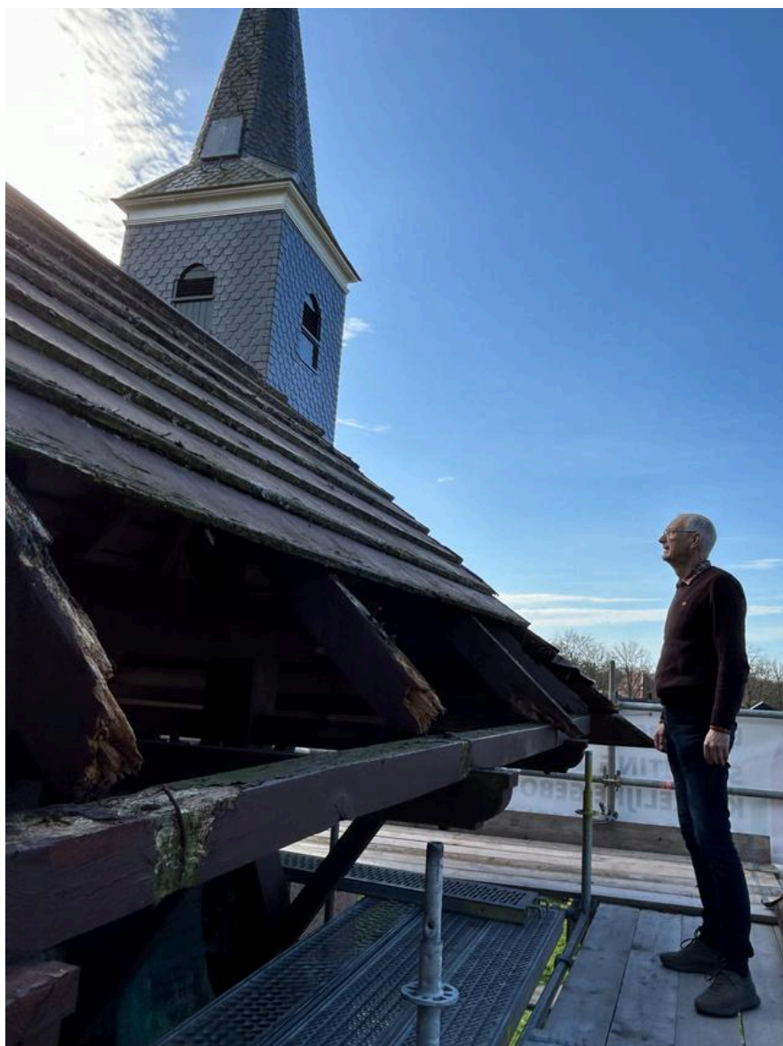
Taeke van der Woude laat de slechte staat van de kap van de klokkenstoel zien. Foto: Susan van Weperen
